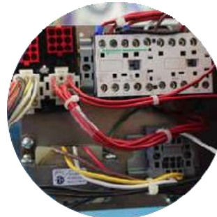
No más cables sueltos
